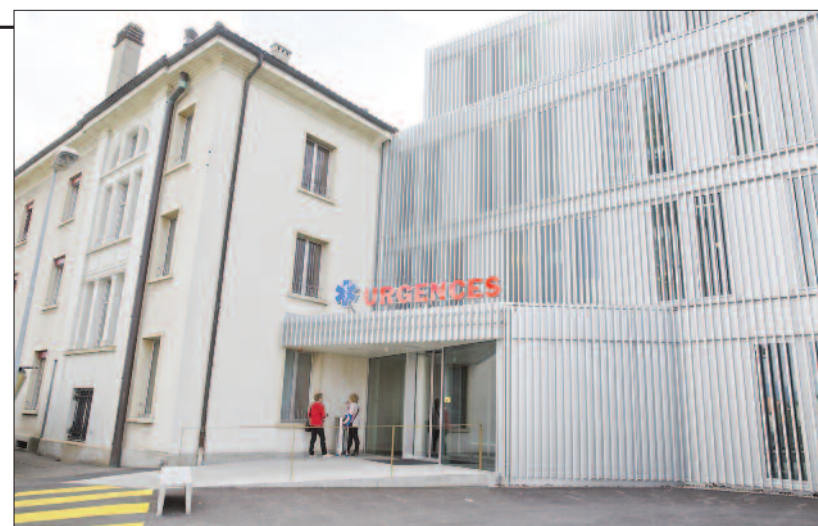
Grâce au nouveau bâtiment, les urgences gagnent de la place. ARCH - R. GAPANY
